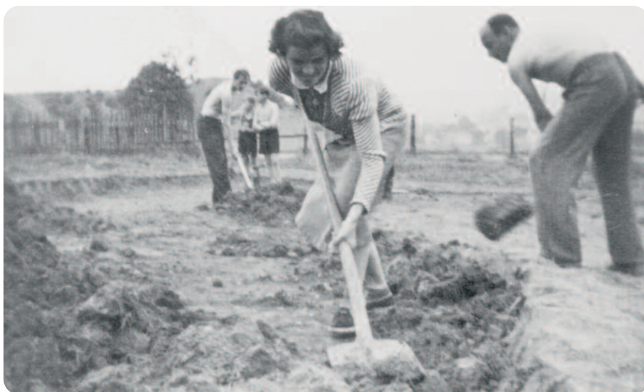
Arbeitseinsatz an der Zechenstraße in Lugau, 1956.
